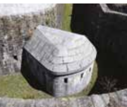
Sopra: interno ed esterno della caponiera. A sinistra: piattaforma girevole dei cannoni.
