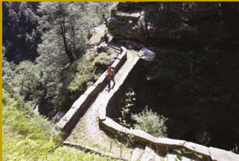
PONT DAL SABION.
